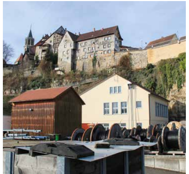
Altes Gaswerk von unten
