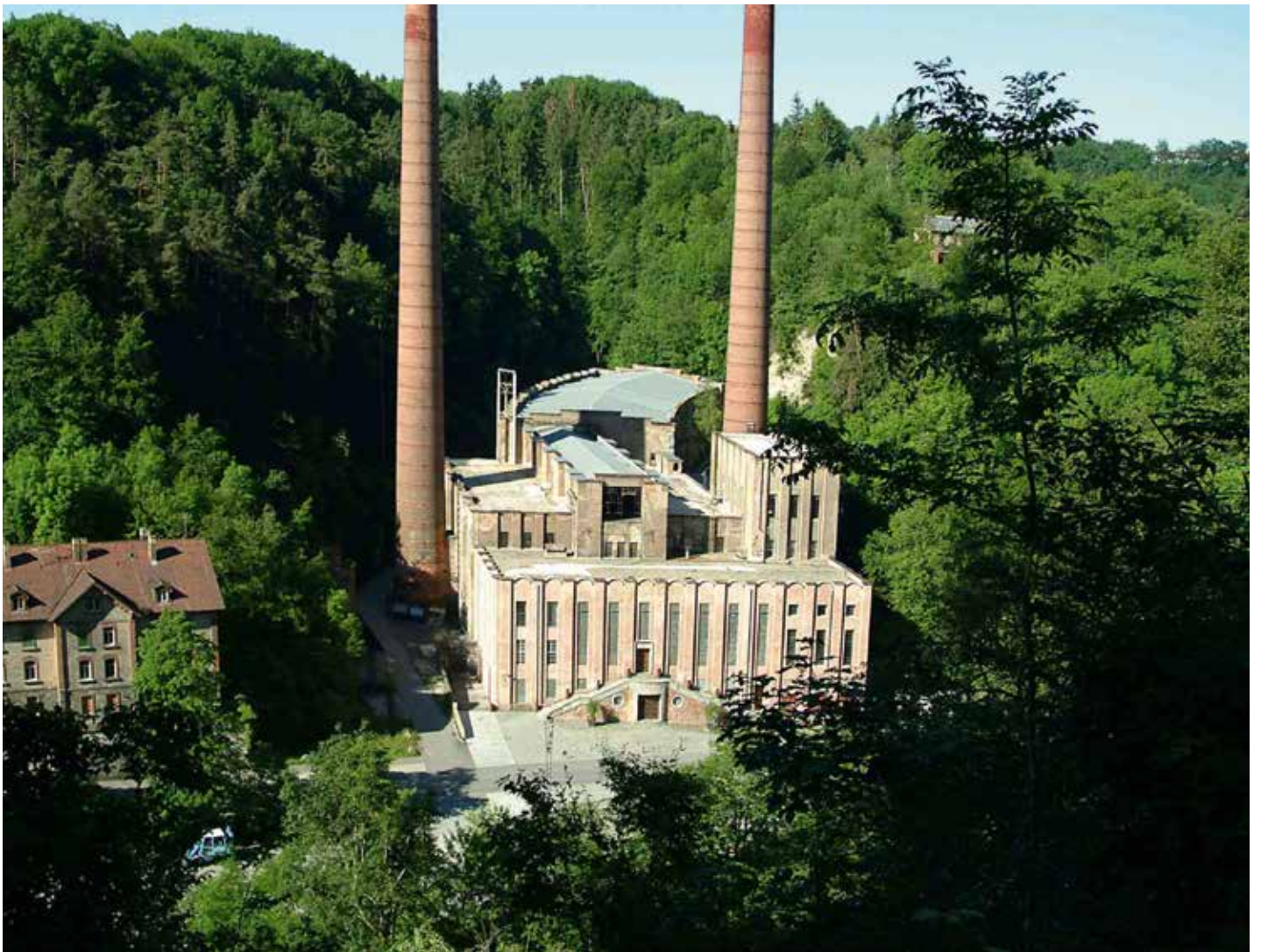
Kraftwerk im Gewerbepark Neckartal
