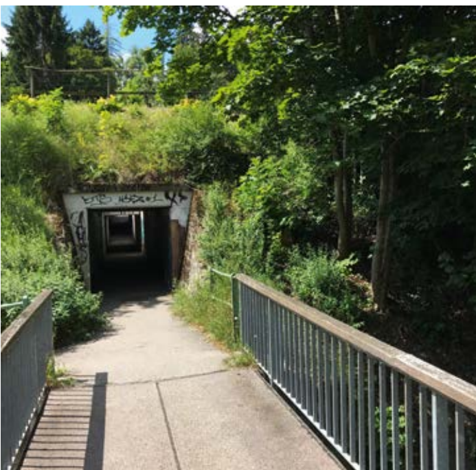
Fußweg unterhalb der Gleise zum Neckar
