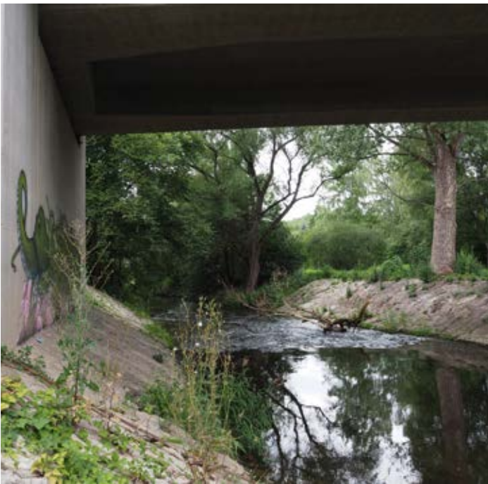
Brücke Lehrstraße nach Süden – keine Verbindung
