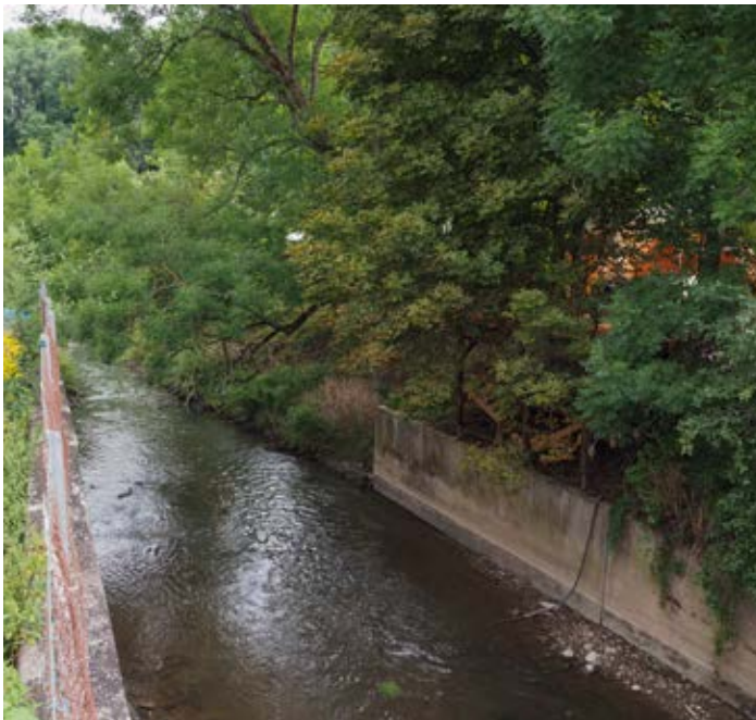
Verbauter Industriekanal nach Norden
