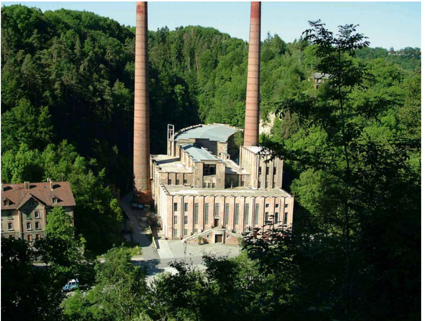
Kraftwerk im Gewerbepark Neckartal
