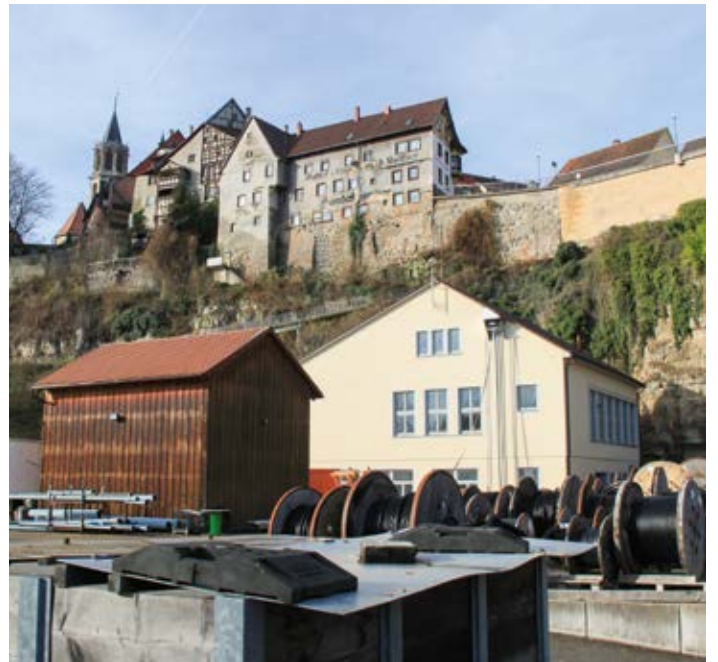
Altes Gaswerk von unten
