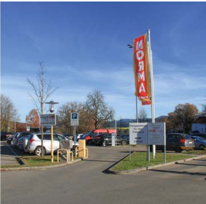
Nägelesgraben und Kriegsdamm am Stadteingang
