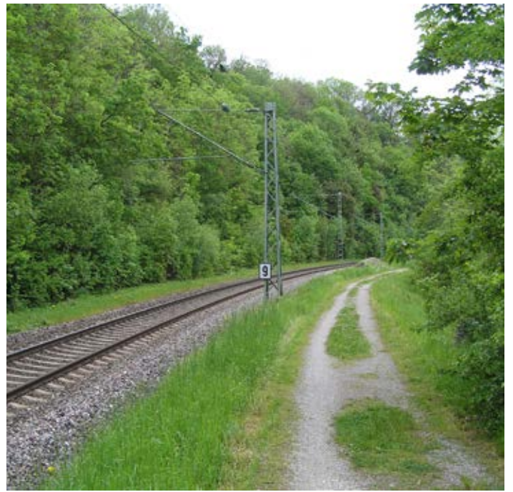
Bestehende Wegeverbindung an den Gleisen
