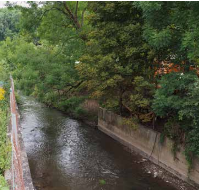
Verbauter Industriekanal nach Norden
