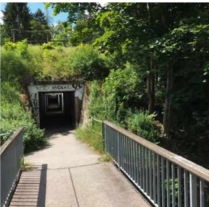
Fußweg unterhalb der Gleise zum Neckar
