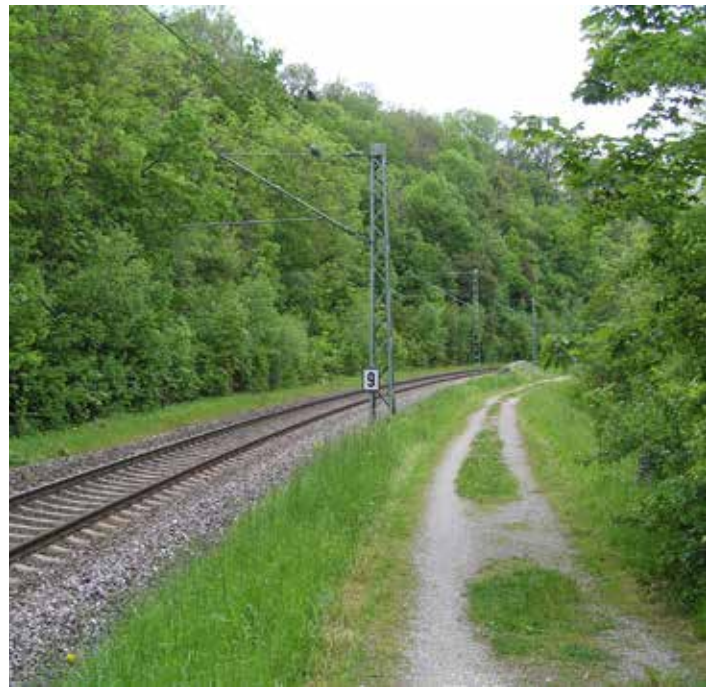
Bestehende Wegeverbindung an den Gleisen
