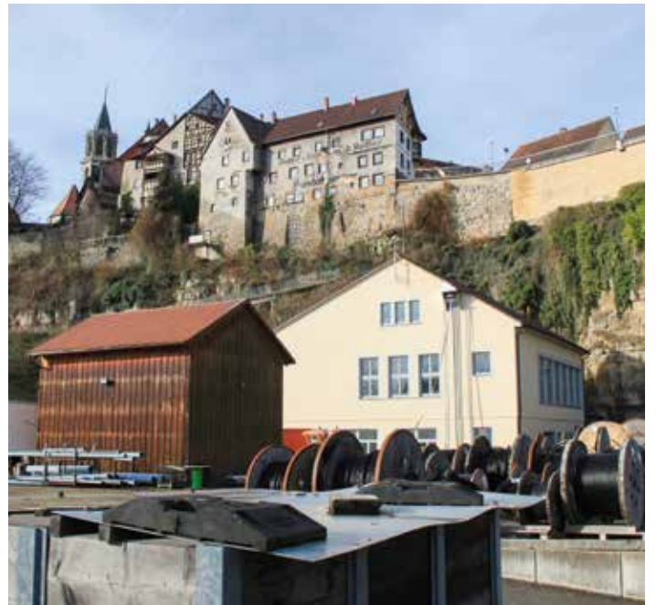
Altes Gaswerk von unten
