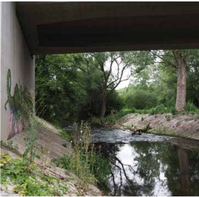
Brücke Lehrstraße nach Süden – keine Verbindung
