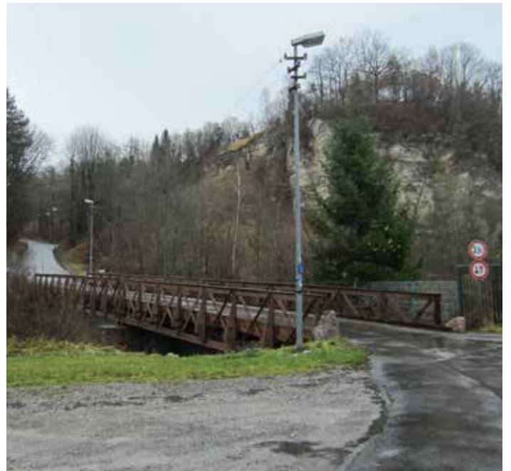
Einspurige Brücke bei der Spittelmühle
